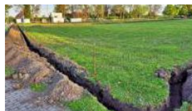
Arbeiten für Leitungsgraben.
