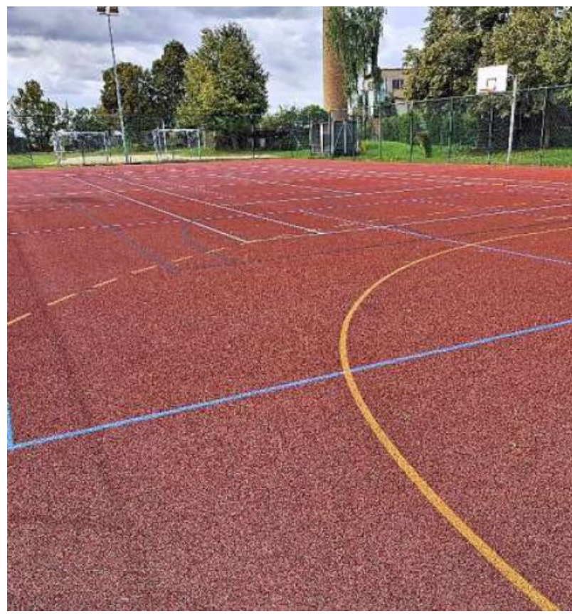
Der Umbau der Sportanlage Atzendorf läuft.
