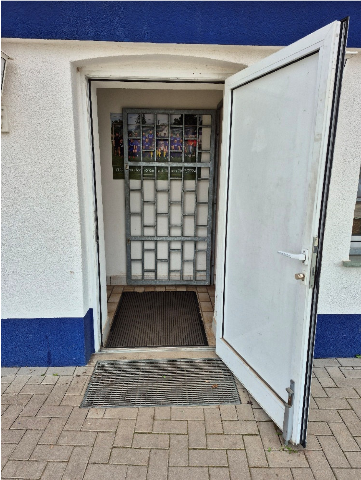
Blick in den Windfang/Türbereiche und Boden
